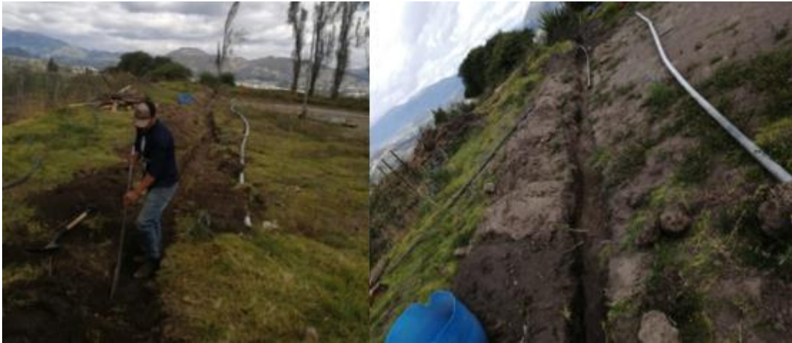
Figura 28-3: Instalación tubería principal Realizado por: Alulema, I, 2022
