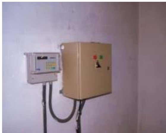
Figura 19-2: Controlador alimentado por corriente eléctrica
