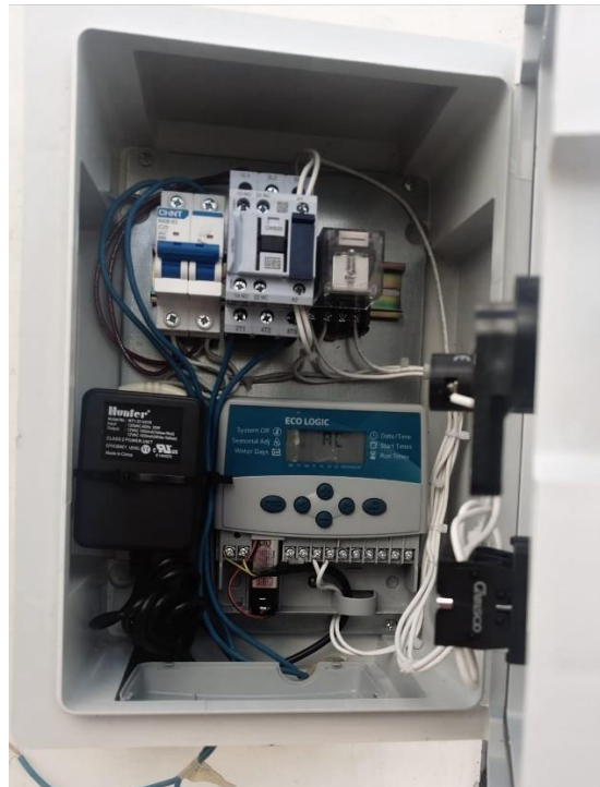
Figura 41-3: Instalación del controlador 6 HUNTER ECO LOGIC 220V Realizado por: Alulema, I, 2022
