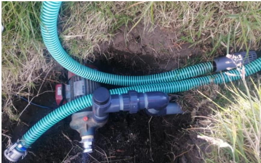
Figura 38-3: Instalación de la bomba, tubería corrugada y válvula de pie
