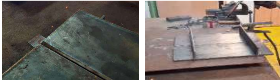
Ilustración 9-3: Placas previo a realizar la unión con proceso FCAW
