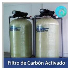
**Figura 6-3:** Filtro Carbón Activado
