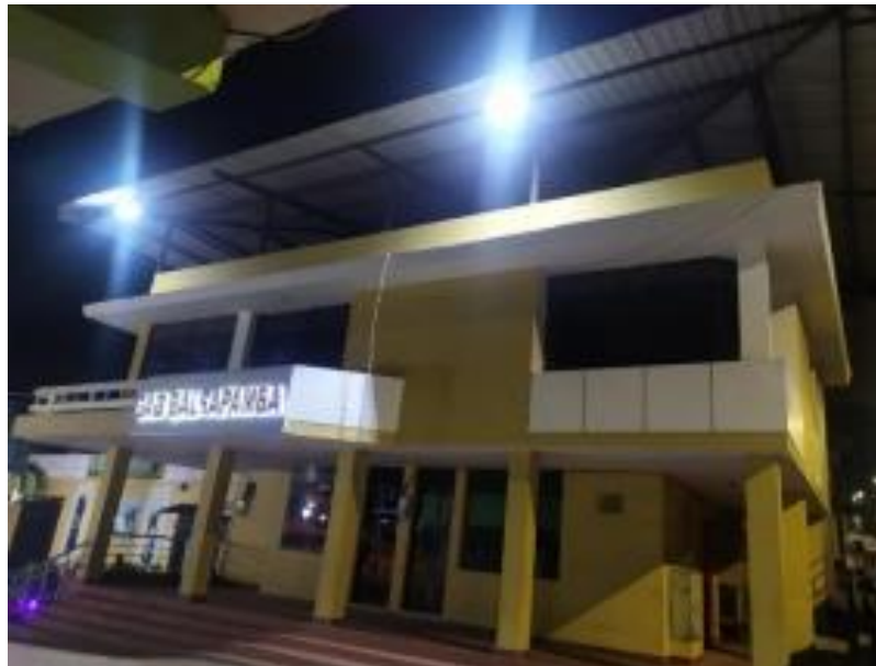
Ilustración 1-5: Instalaciones de GAD Parroquial de Balsapamba
