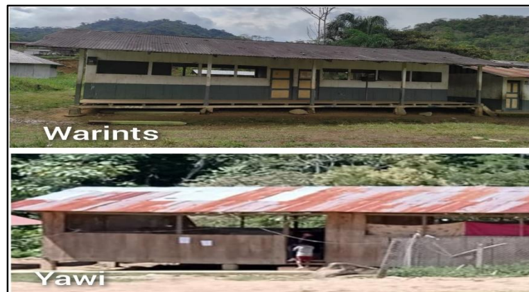
Figura 4-4. Infraestructura de aulas escolares antes de la llegada de la minera Lowell.
