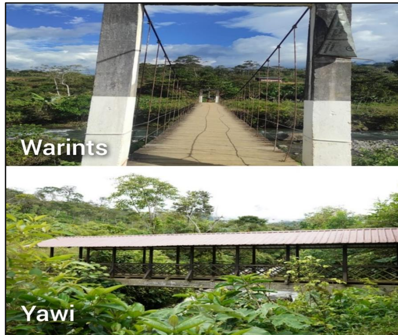
Figura 8-4. Construcción y mantenimiento de puentes Warints – Yawi.
