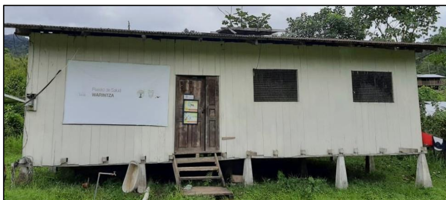
Figura 1-4. Infraestructura del subcentro de salud Warints – 2019.
