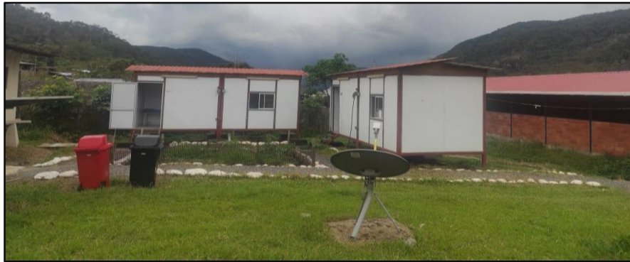
Figura 2-4. Infraestructura del subcentro de salud warints – 2020.
