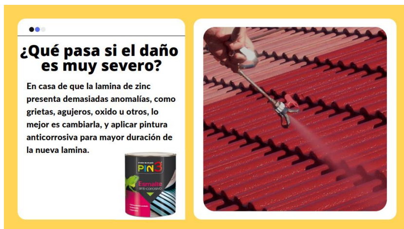
Figura 7-3: Qué pasa si el daño es muy severo Realizado por: Ramos, A. (2022)
