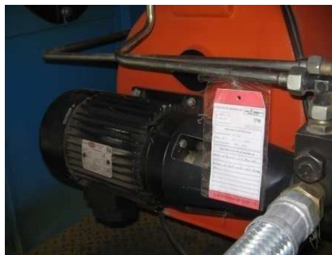
Figura 5.9. Etiquetado de Anomalías en la Bomba de Alimentación al Quemador
