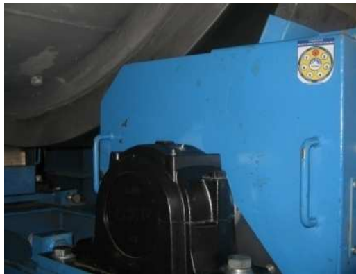
Figura 5.8. Etiquetado Primera Etapa del Mantenimiento Autónomo Tablero de Control del Quemador para el Secador Rotativo de Puzolana
