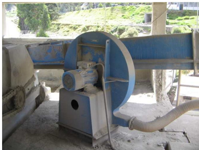
Figura 3.12. Sopladores de Alimentación de Aire
