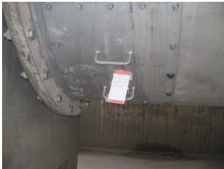
Figura 5.7. Etiquetado en la Limpieza Inicial en el Secador Rotativo de Puzolana
