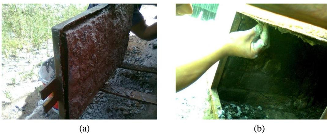
**Figura 4.7:** colocación de material refractario: a) en las tapas, b) en las paredes interiores.
