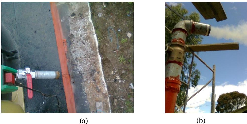
**Figura 4.17:** a) verificación de fugas, b) producción normal de gas.
