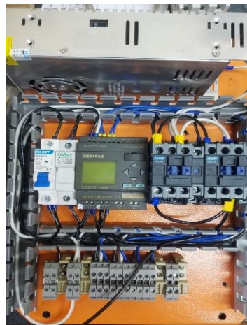
Figura 14-3: Armado del nuevo tablero de control Realizado por: Acán, J.; Paucar, B. 2022
