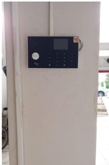
Figura 18-3: Instalación de la nueva alarma
