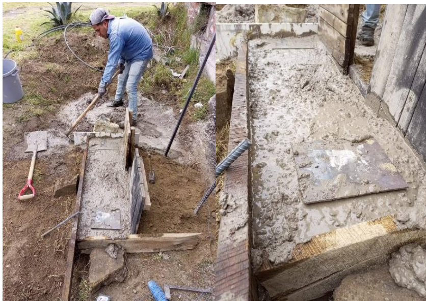
Figura 42-4: Cimentación para escalera pequeña
