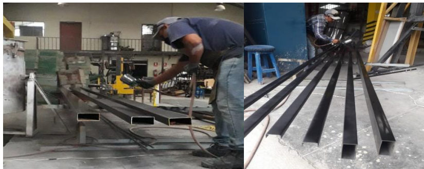
Figura 6-4: Aplicación de pintura anticorrosiva norma SSPC PA1
