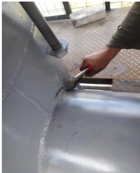
Figura 52-4: Limpieza de cordones de soldadura
