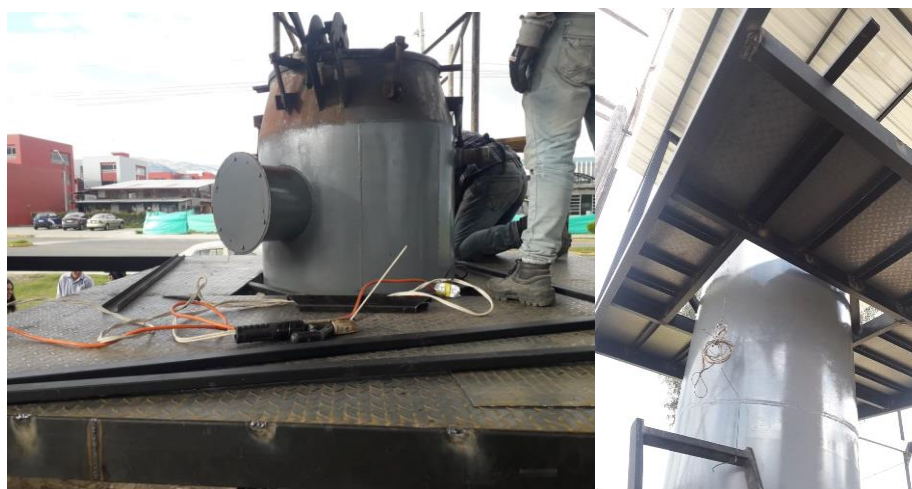
Figura 22-4: Colocación de plancha antideslizante
