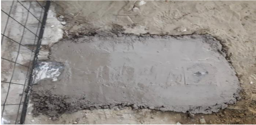
Figura 39-4: Cimentación para la escalera grande
