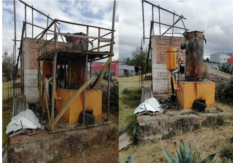
Figura 2-4: Limpieza del área de trabajo
