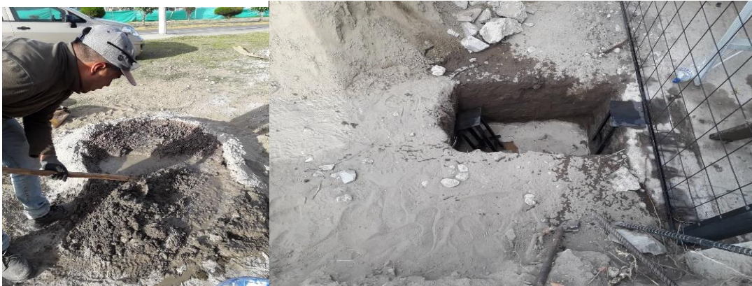
Figura 38-4: Mezcla de concreto, bases de acero
