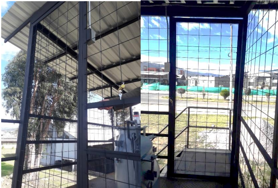
Figura 34-4: Puerta de ingreso a la planta alta del gasificador
