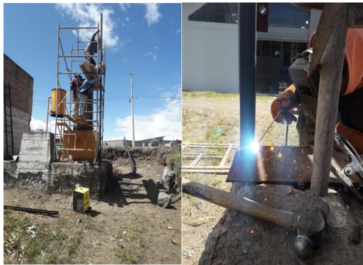
Figura 12-4: Andamios para montaje de tubería rectangular
