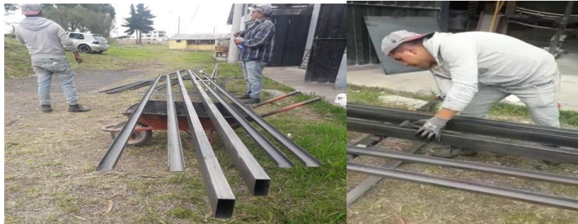
Figura 5-4: Limpieza bajo la norma SSPSC-SP1, SSPSC SP2
