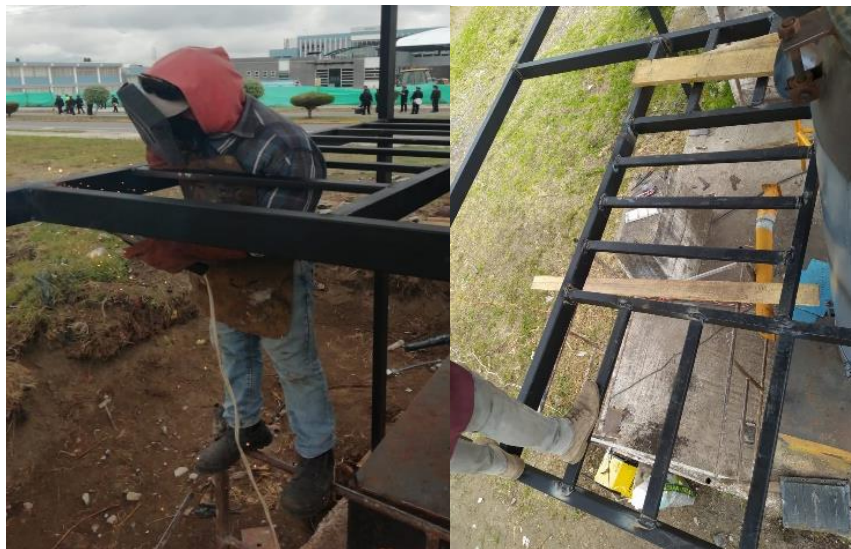
Figura 20-4: Ensamble de perfiles para el piso
