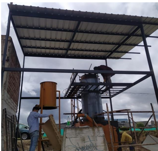
Figura 21-4: Base de piso para el gasificador
