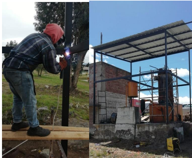
Figura 16-4: Marco para el piso con tubería rectangular
