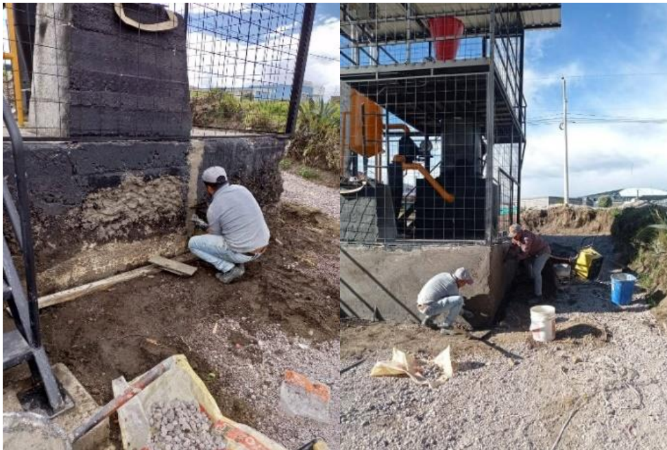
Figura 62-4: Enlucida de las caras de la cimentación
