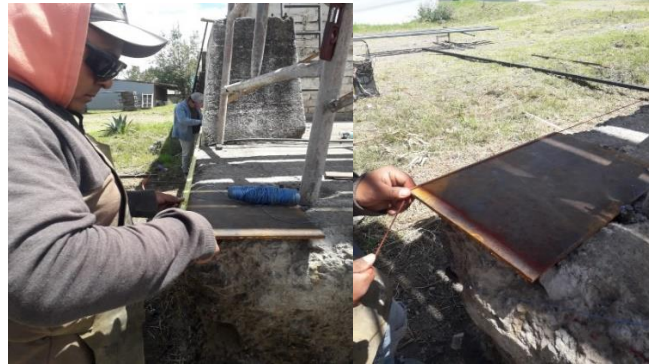
Figura 9-4: Medidas en la base de la cimentación
