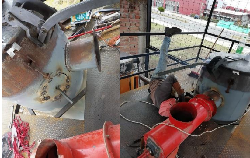
Figura 27-4: Colocación del sistema de alimentación
