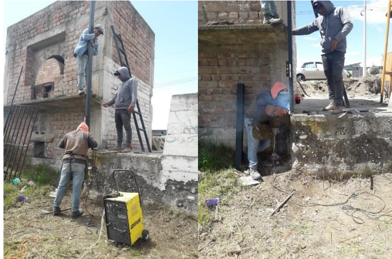
Figura 11-4: Soldadura de la tubería rectangular
