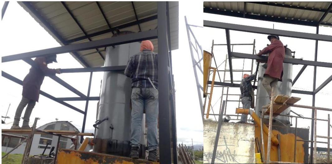
Figura 17-4: Armado del piso para el gasificador
