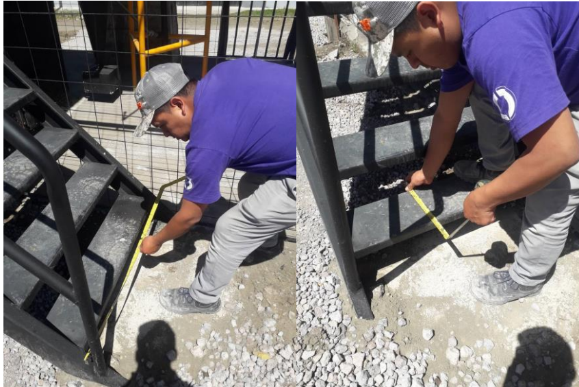
Figura 49-4: Comprobación de medidas de las escaleras
