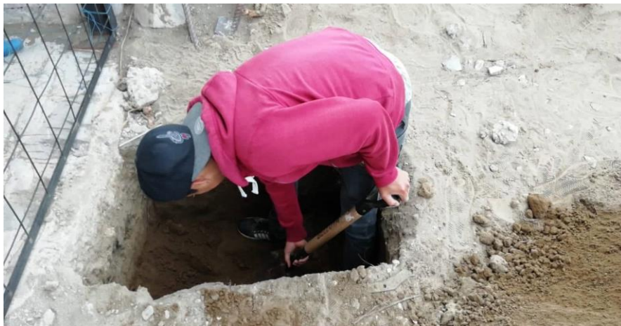
Figura 36-4: Zanja para escalera grande
