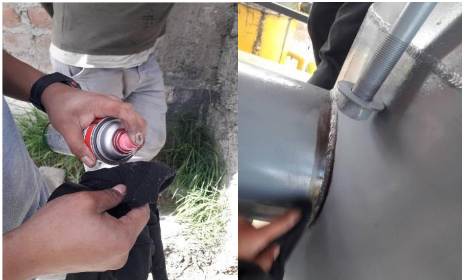
Figura 54-4: Aplicación de removedor
