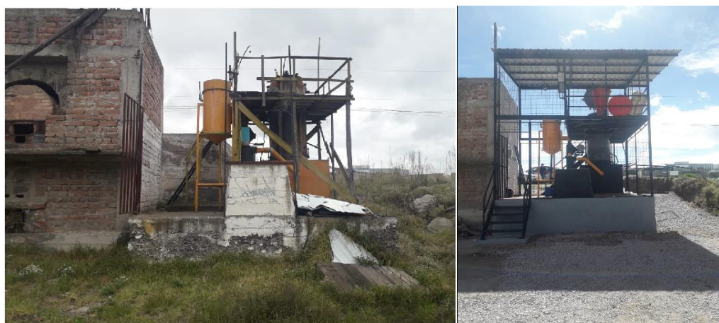
Figura 1-4: Estado de situación inicial vs la implementación de la estructura metálica
