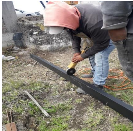
Figura 10-4: Trazado y corte de tubería
