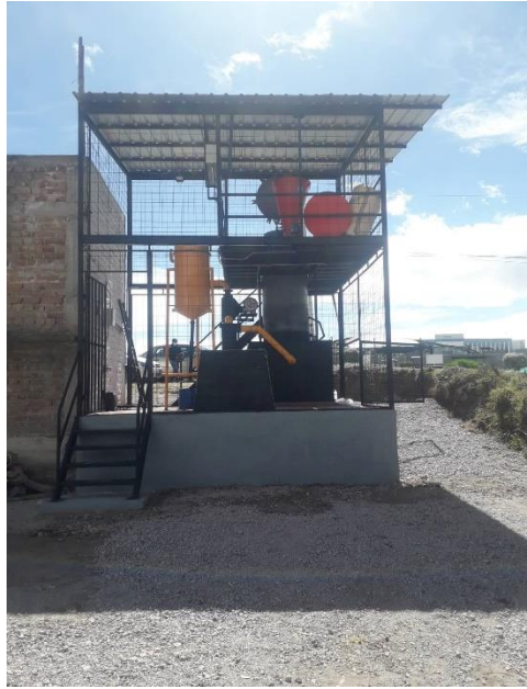
Figura 63-4: Acabados de la cimentación.
