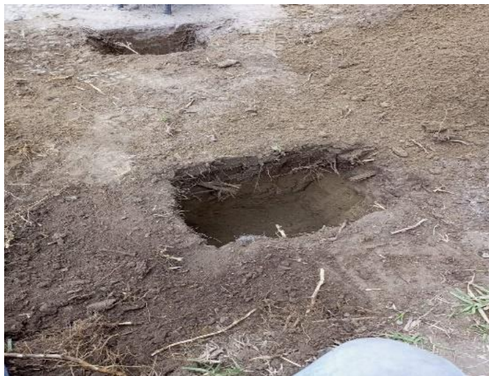
Figura 40-4: Zanjas para cimentación
