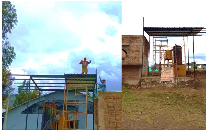
Figura 15-4: Colocación de dura techo
