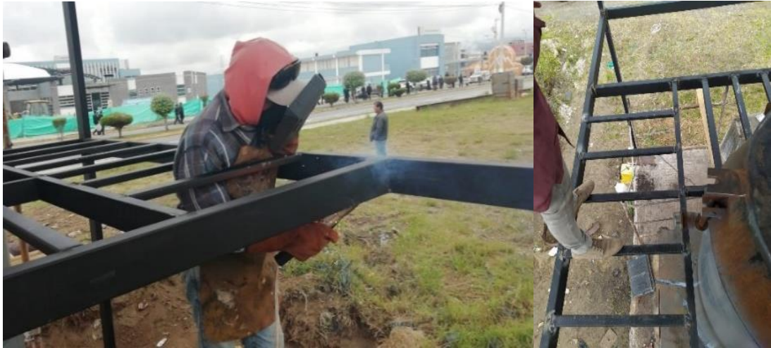
Figura 19-4: Ensamble de perfil canal U
