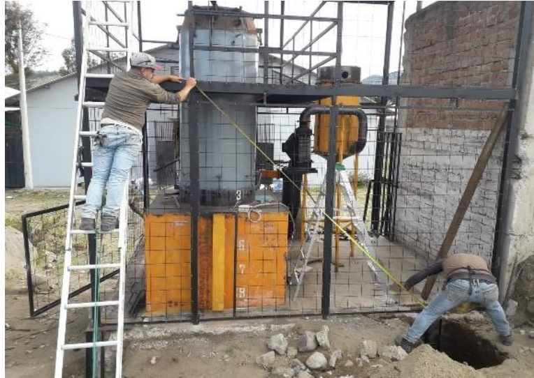
Figura 37-4: Medidas y nivel del descanso
