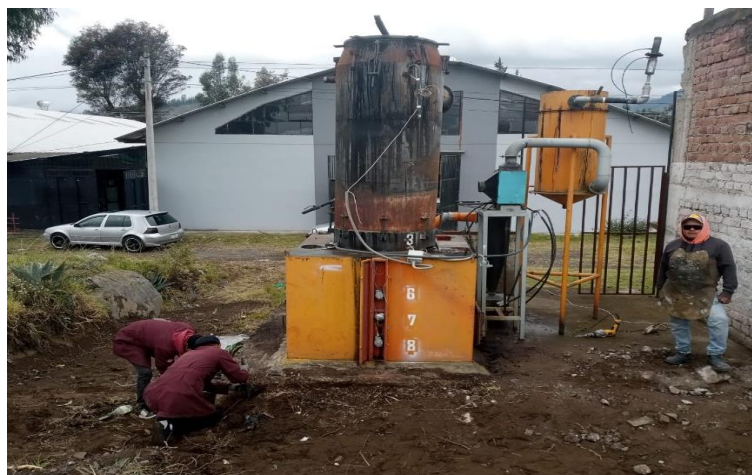
Figura 4-4: Limpieza total del gasificador.
