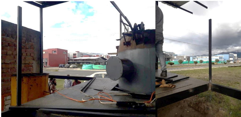
Figura 23-4: Montaje de pasamanos
