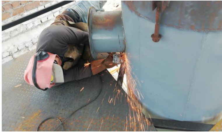
Figura 25-4: Desoldado de toma del sistema de alimentación
