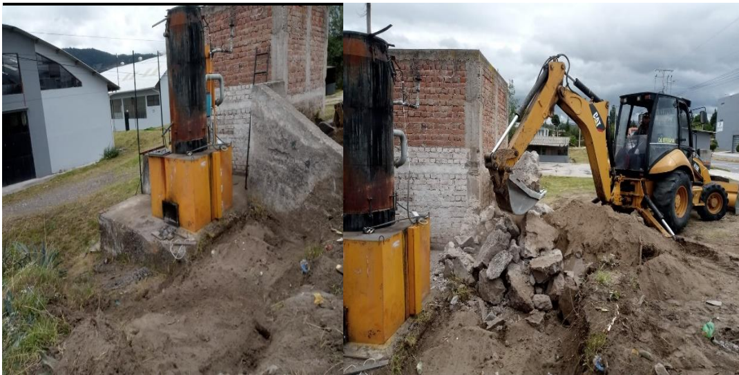
Figura 3-4: Retiro de muro de concreto
