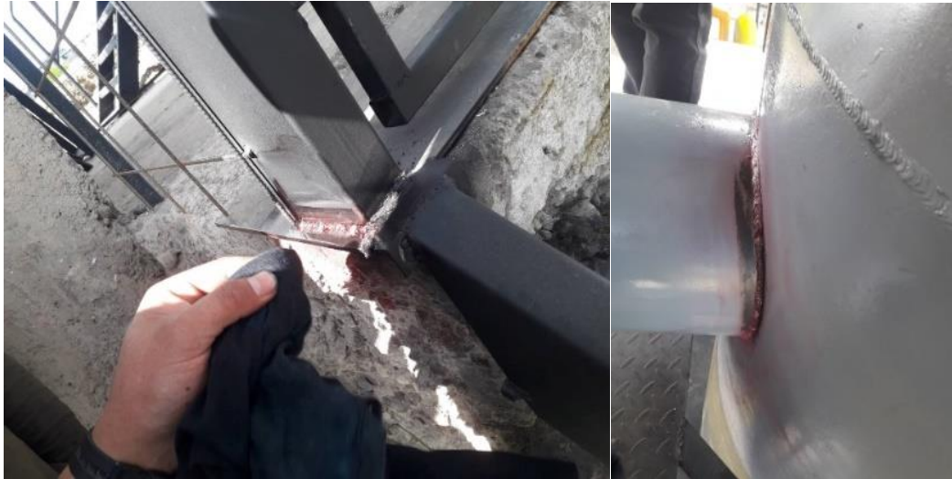
Figura 57-4: Retiro de exceso de penetrante
