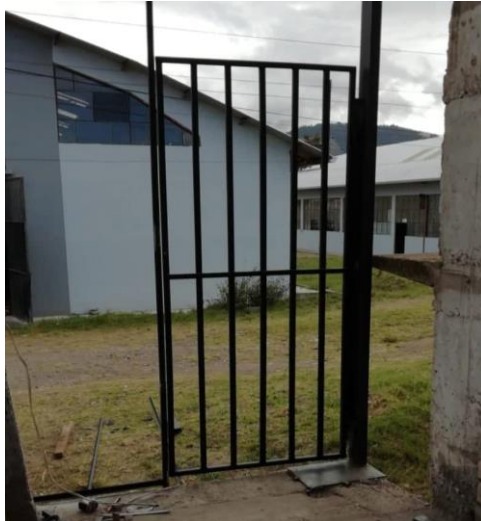
Figura 29-4: Instalación de puerta
