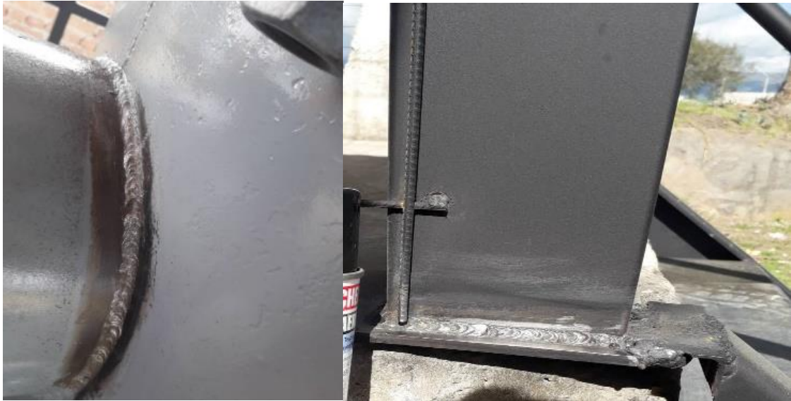
Figura 53-4: Limpieza total de los cordones
