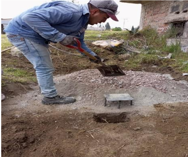
Figura 41-4: Mezcla de concreto
