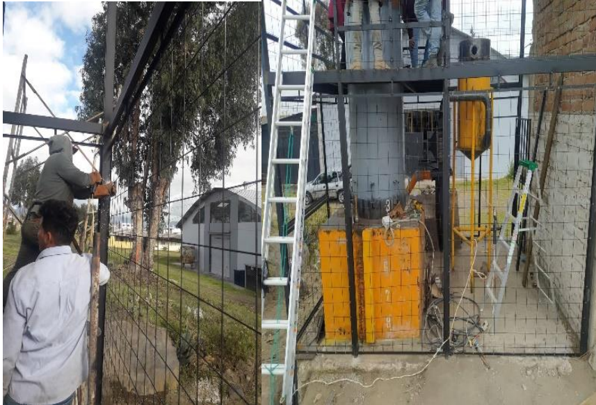
Figura 35-4: Colocación de malla electro soldada
