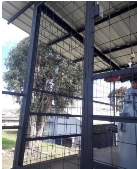
Figura 48-4: Comprobación de medidas de las puertas
