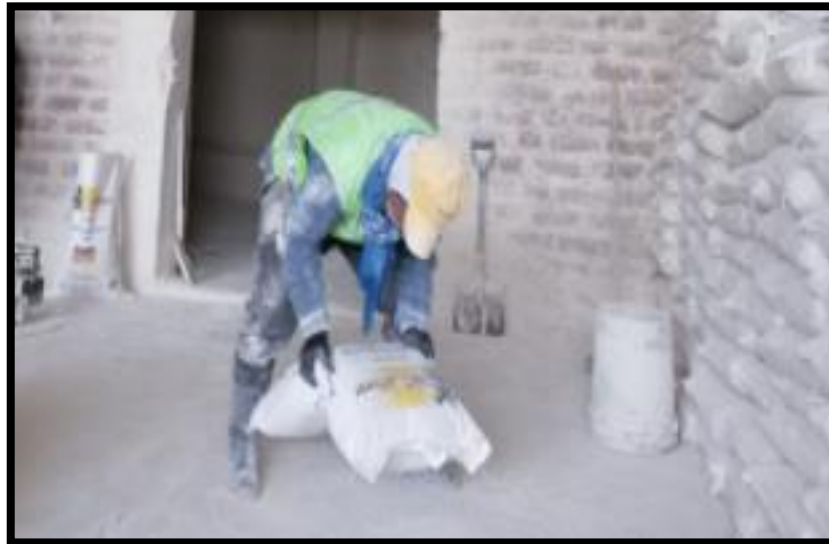
Ilustración 18-3: Levantamiento y transporte de los sacos
