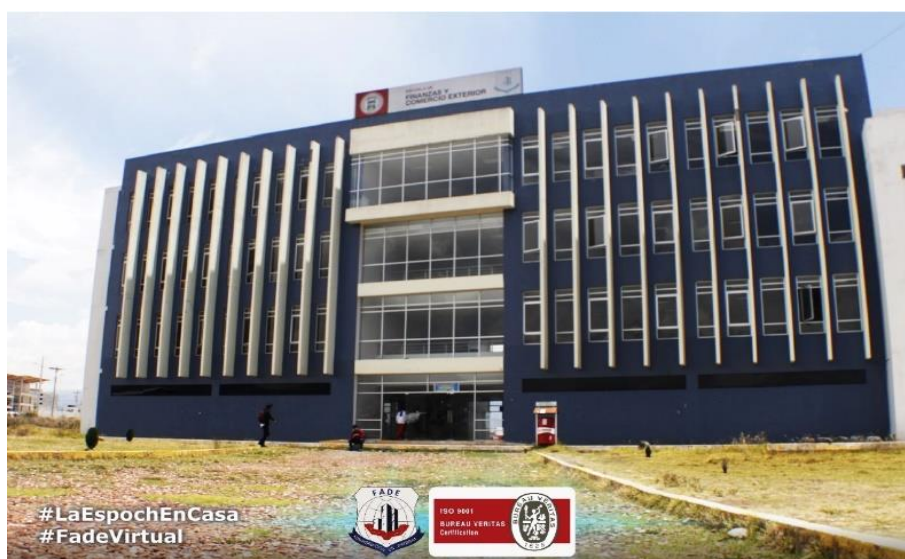
Ilustración 1-5: Edificio de Finanzas
