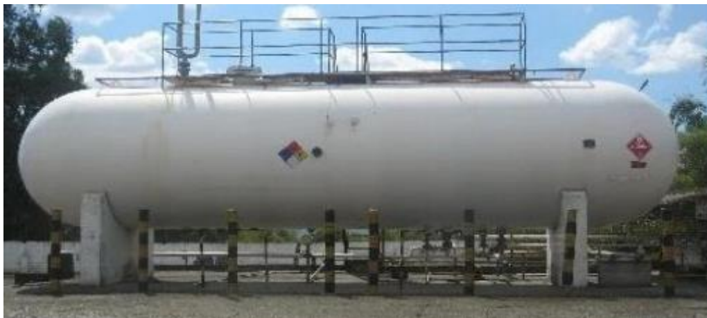
Ilustración 3-2: Tanque cilíndrico horizontal.
