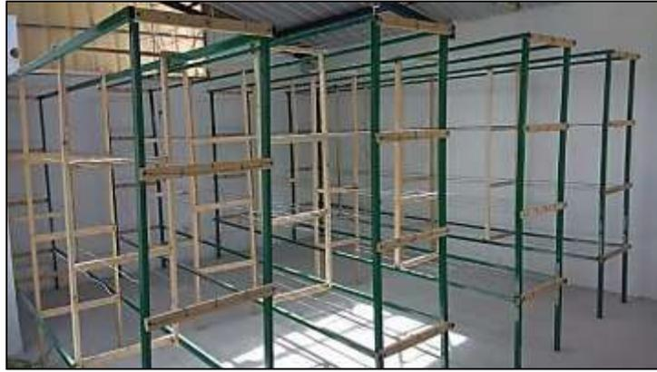
**Figura 24-3.** Estructura de soporte de romero implementada
