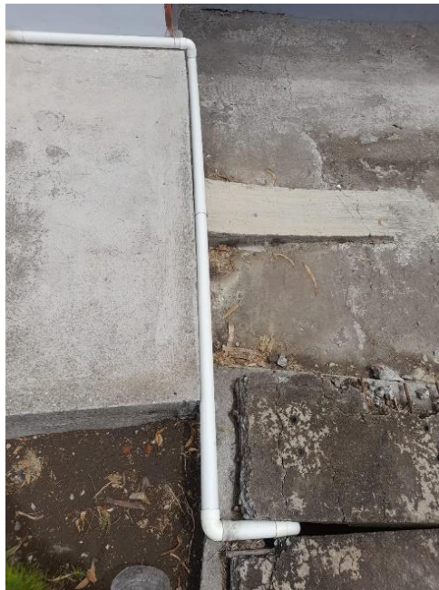
Ilustración 19-4: Conexión del desfogue al sumidero
