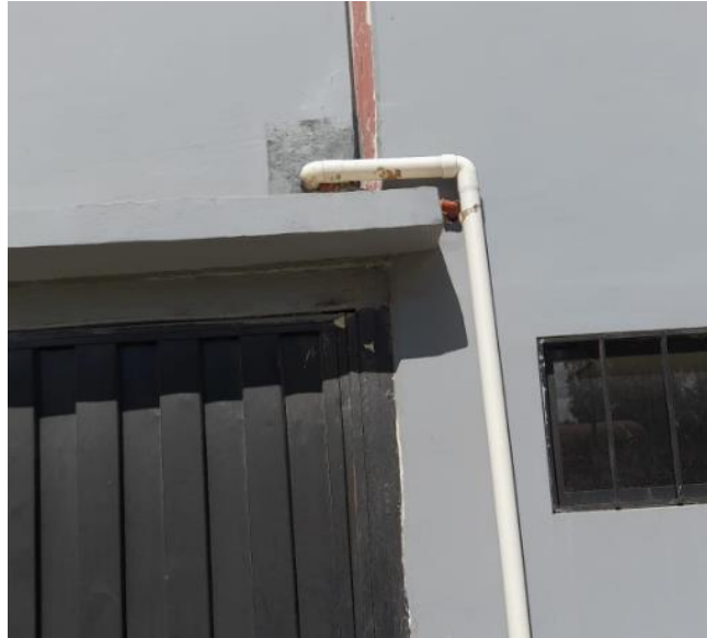
Ilustración 17-4: Perforación de pared y tubería al primer piso
