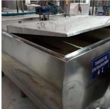
Ilustración 14-3: Tanque de enfriamiento para producto terminado
