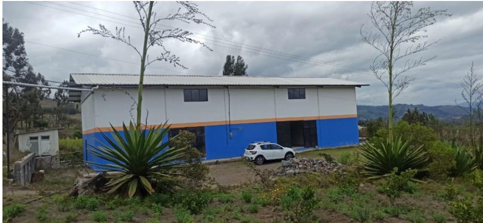
Ilustración 17-4: Nave industrial agrícola ASOPROGF.
