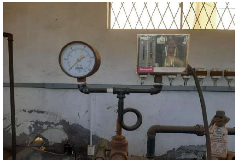
Ilustración 3-9: Presostato cola de cerdo
