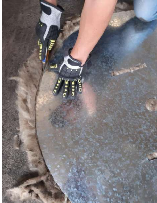
Ilustración 3-52: Corte y adaptación del aislante Realizado por: Jimenez, R, 2023.
