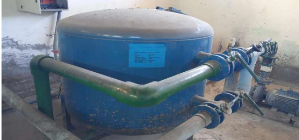
Ilustración 3-6: Filtro vertical de presión
