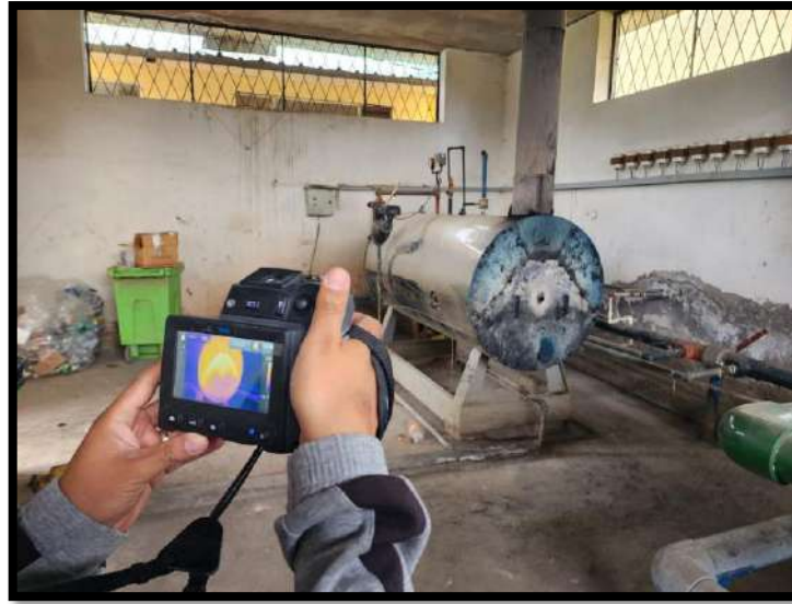
Ilustración 3-18: Uso de la cámara termográfica
