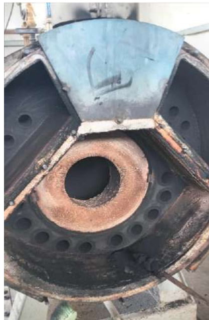
Ilustración 4-7: Limpieza de tubos
