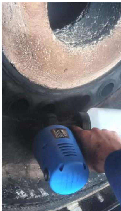
Ilustración 4-8: Sopleteado de tubos
