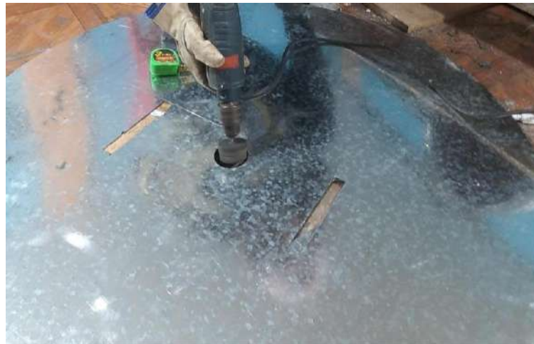
Ilustración 3-51: Perforación de agujeros
