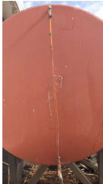
Ilustración 3-75: Medidor de nivel
