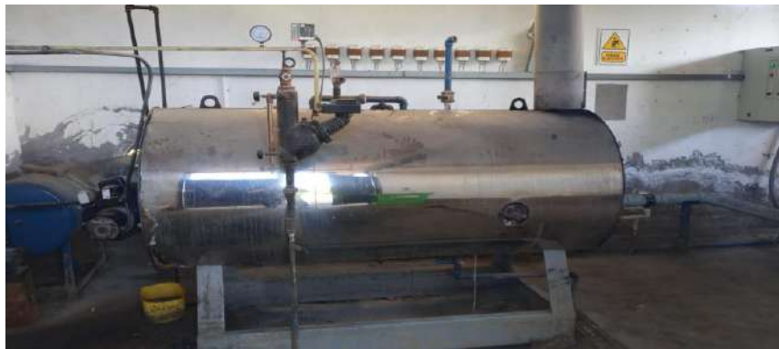
Ilustración 3-4: Caldera piro tubular
