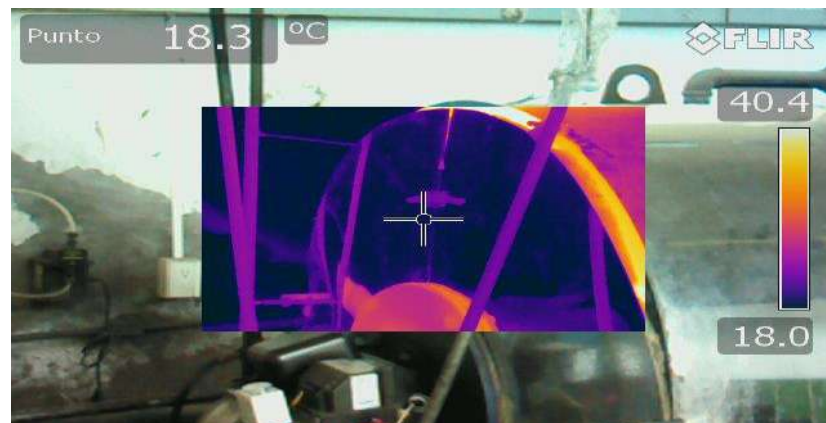
Ilustración 4-15: Imagen termográfica de la cara frontal con aislamiento
