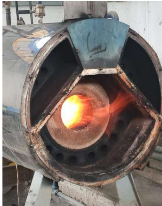
Ilustración 4-10: Combustión descalibrada
