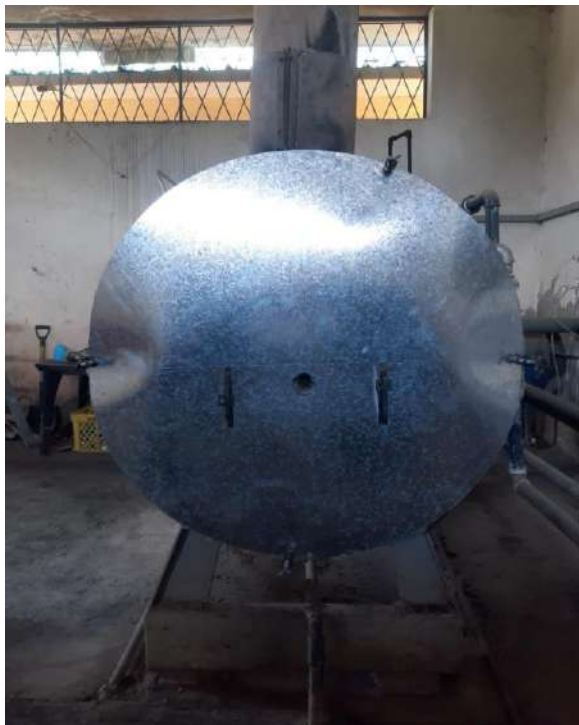
Ilustración 3-55: Aislamiento pared posterior
