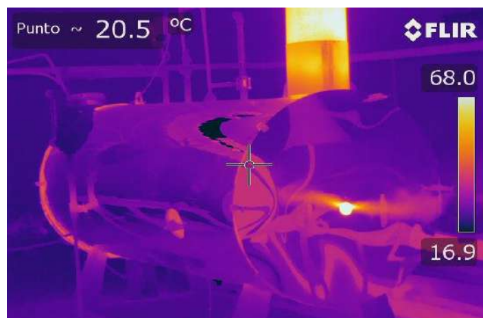
Ilustración 4-12: Imagen termográfica con aislamiento
