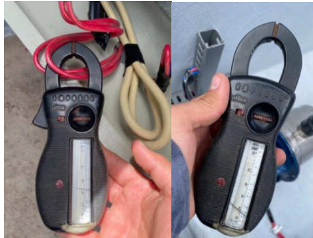
Ilustración 4-22: Verificación corriente eléctrica. Realizado por: Abarca M., Hernández L., 2023
