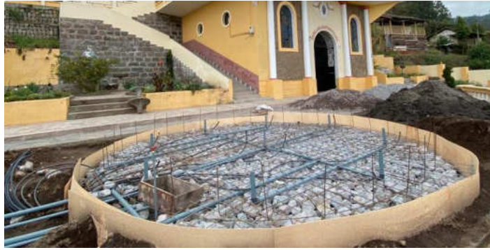
Ilustración 4-2: Red de tuberías, fijación de malla y varilla Realizado por: Abarca M., Hernández L., 2023
