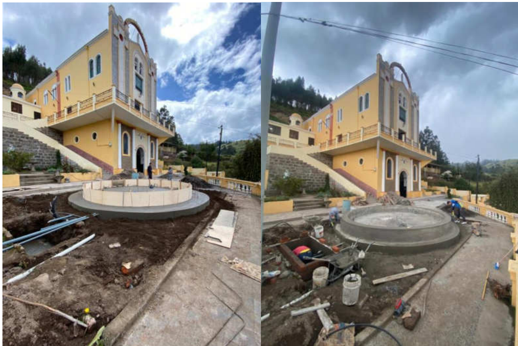
Ilustración 4-3: Fundición de hormigón base y paredes de la fuente. Realizado por: Abarca M., Hernández L., 2023
