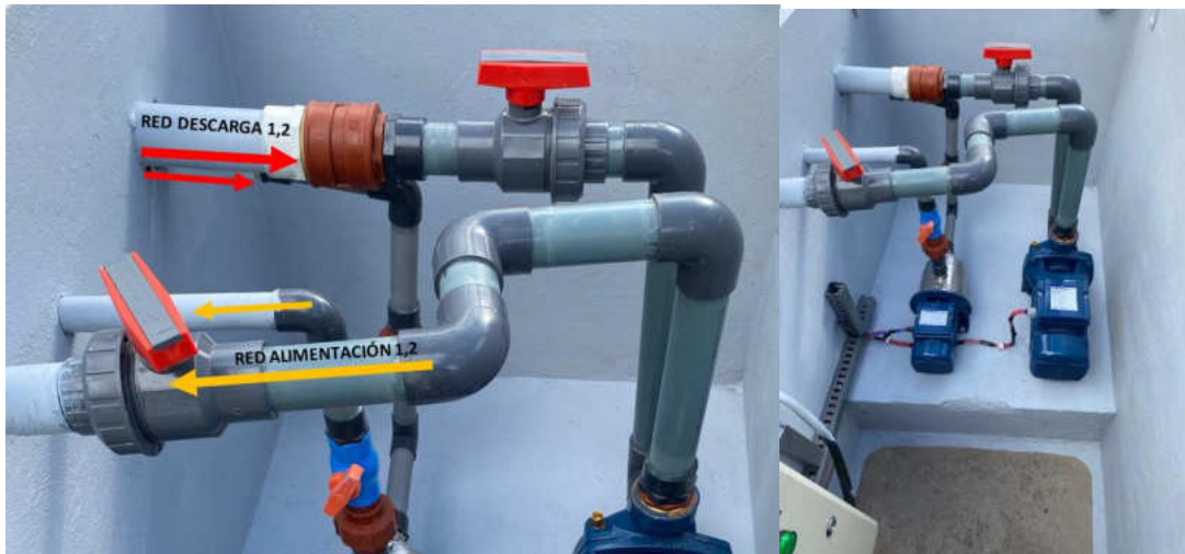
Ilustración 4-4: Canalización red de tuberías, instalación sistema de bombeo.
