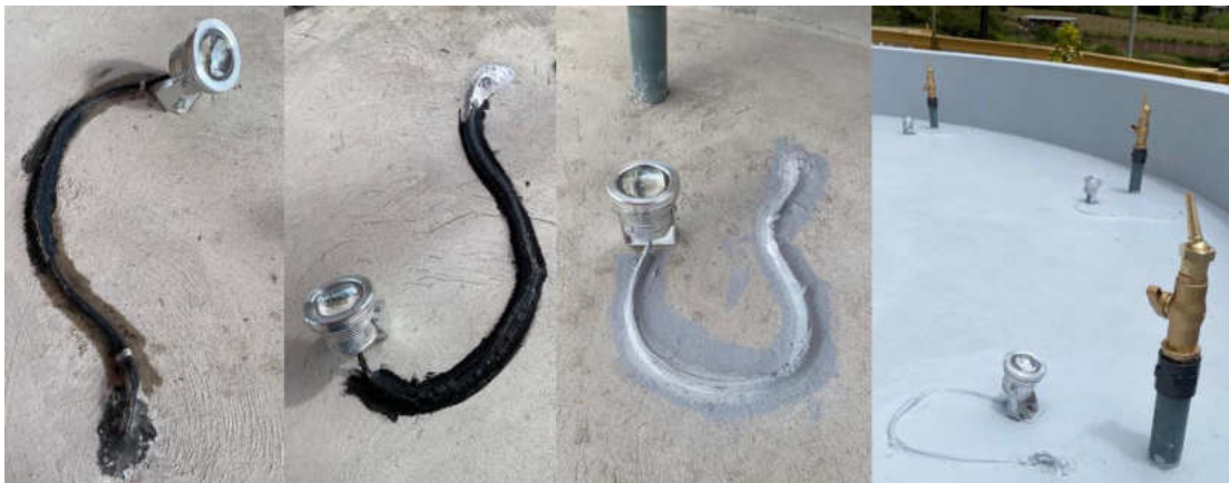
Ilustración 4-6: Instalación e impermeabilización de las redes de iluminación Realizado por: Abarca M., Hernández L., 2023
