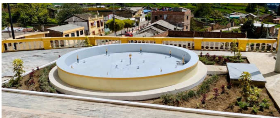
Ilustración 4-8: Impermeabilización paredes y fondo de la fuente Realizado por: Abarca M., Hernández L., 2023
