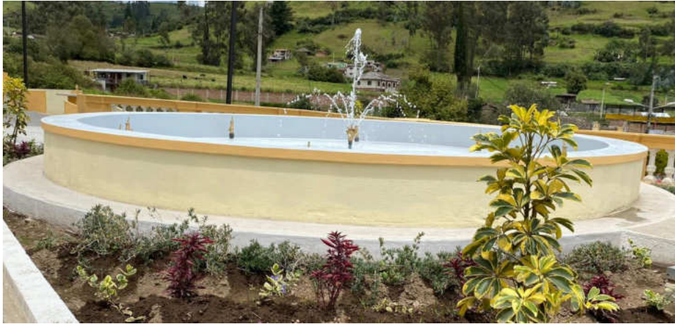
Ilustración 4-18: Tobera central operando en el punto de diseñado. Realizado por: Abarca M., Hernández L., 2023
