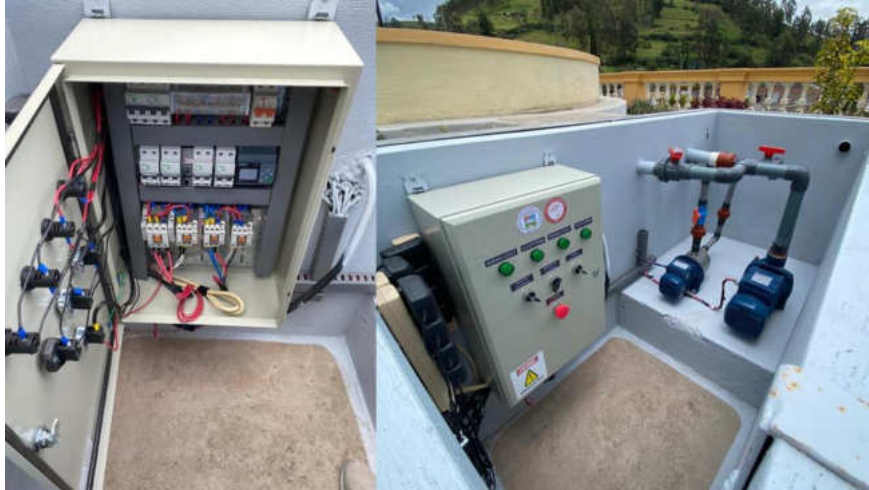
Ilustración 4-10: Montaje del tablero de control Realizado por: Abarca M., Hernández L., 2023
