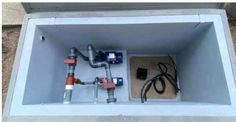
Ilustración 4-7: Impermeabilización del cuarto de control Realizado por: Abarca M., Hernández L., 2023
