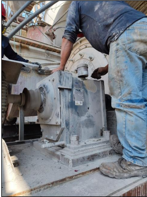
Ilustración 13-3: Limpieza de la superficie en la bayoneta
