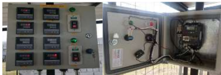
Ilustración 2-3: Energizar los tableros
