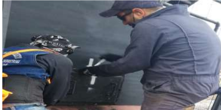
Ilustración 4-3: Cerrado de las tapas de los lados del sub-reactor
