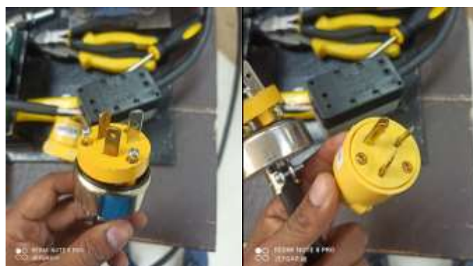
Ilustración 2-3: Sustitución del enchufe Realizado por: García Jefferson, 2023
