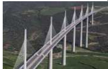
Estructuras metálicas 1 €/kg
