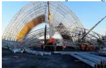
Viaductos monumentales 5 €/kg
