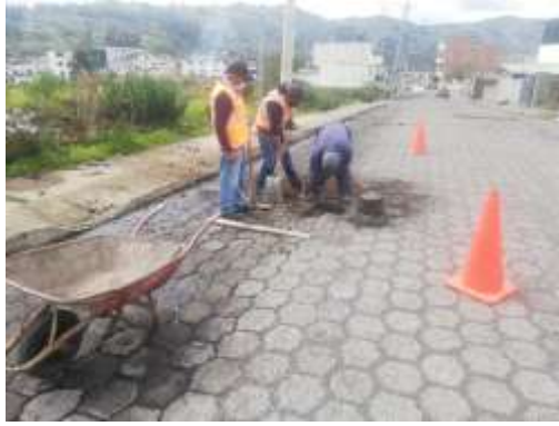
Ilustración 3-6: Señalización y adoquinado Realizado por: Paca Carlos. 2023.
