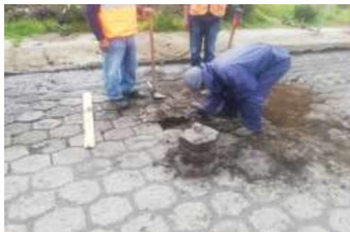
Ilustración 3-5: Colocación de adoquín
