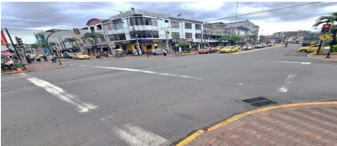
Figura 65-4. Imagen de la intersección 12 de Febrero y Av. Quito Fotografía: González, José, 2021
