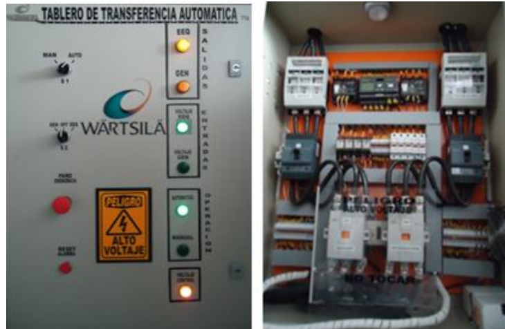
Figura III.41. Construcción del circuito de Señalización.
