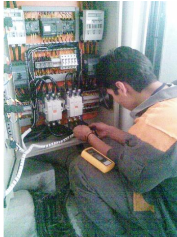
Figura V.68. Comprobación de Fases
