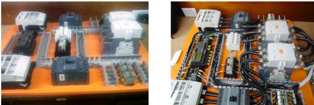
Figura III.38. Construcción del circuito de Potencia
