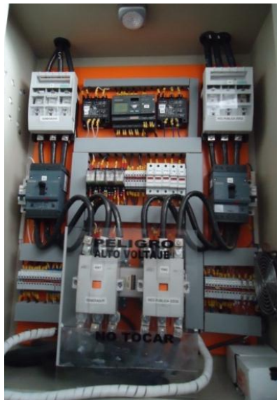
Figura V.69. Vista Frontal del Interior del TTA
