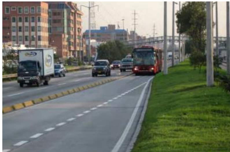
Ilustración 2-4: Separador de carriles
