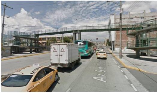
Puente peatonal UE. Chiriboga
