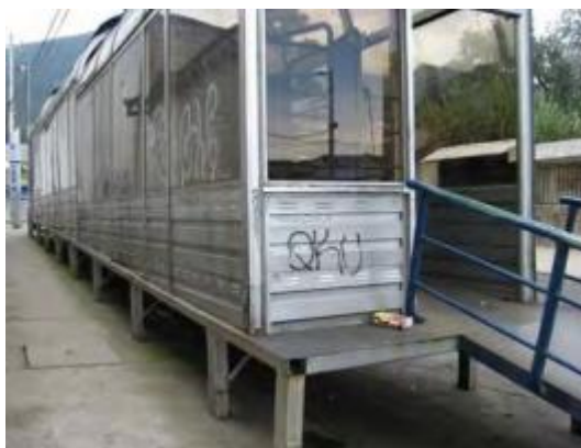
Ilustración 2-3: Estaciones de Quito BRT
