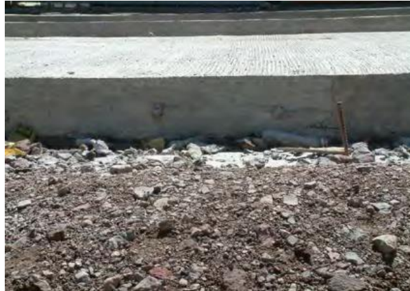
Ilustración 2-2: Vía de hormigón BRT
