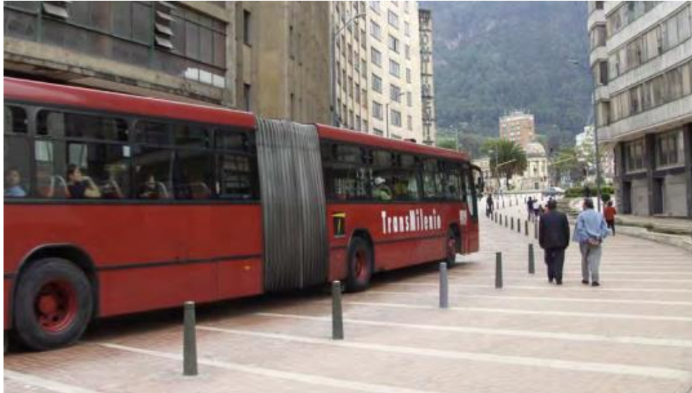
Ilustración 2-5: Bolardos separador vías Bogotá
