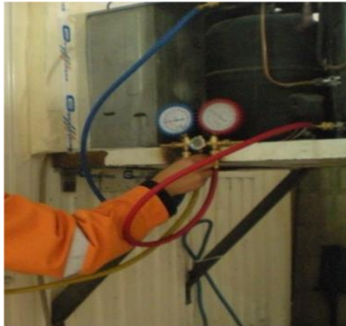
Figura V.128. Realizando la Purga para cargar Gas R22
