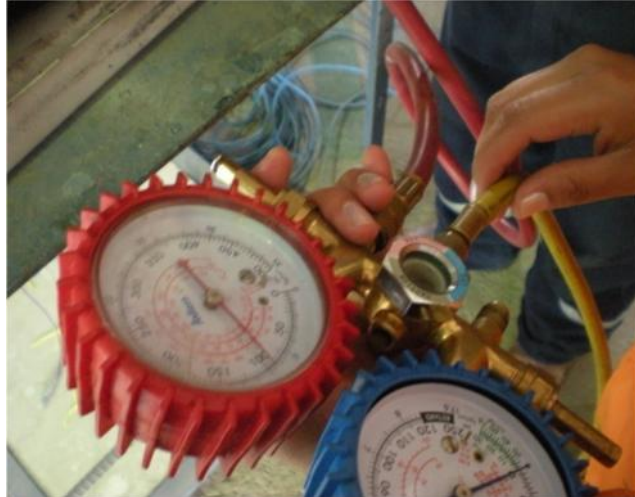
Figura V.109. Probando el funcionamiento del aire acondicionado
