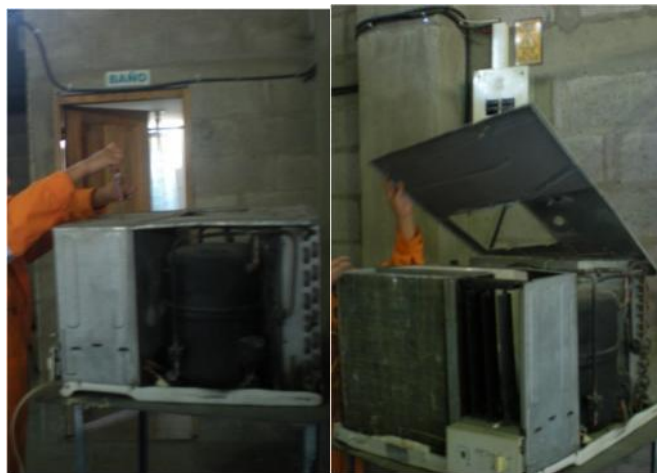
Figura V.110. Desarmando el aire acondicionado
