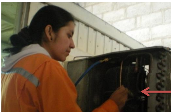
Figura V.123. Verificación de fugas
