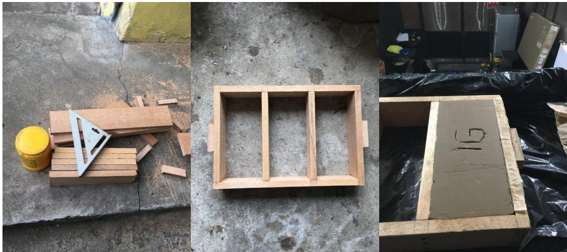
Ilustración 14-3: Fabricación de moldes y proceso de moldeo
