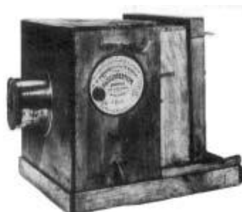
Figura II.8 Cámara Daguerrotipo construida en 1839.
