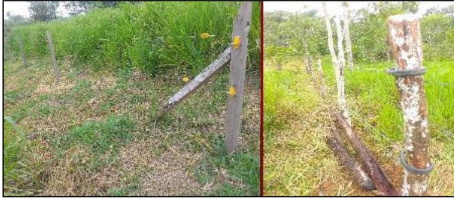
**Ilustración 4-10:** Postes esquinero con pie de apoyo y poste vivo de inicio de sección
