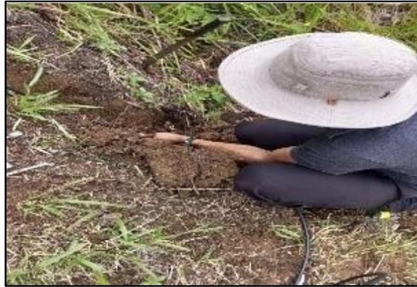
**Ilustración 4-37:** Demostración de la incorporación de barras de tierra adicionales
