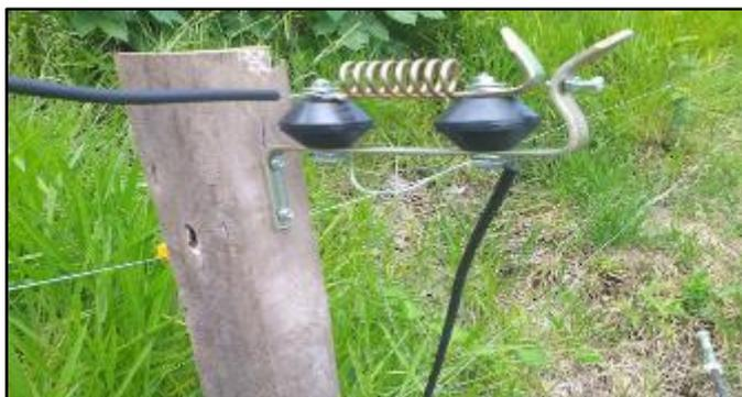
**Ilustración 4-23:** Demostración de instalación del sistema de pararrayos o desviador de rayos
