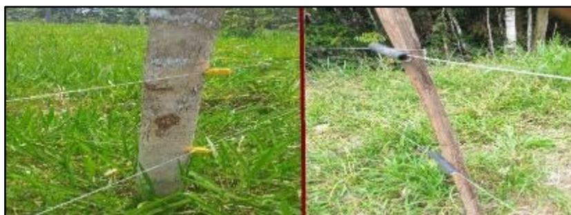
**Ilustración 4-11:** Postes con aisladores de puntilla y manguera aisladora
