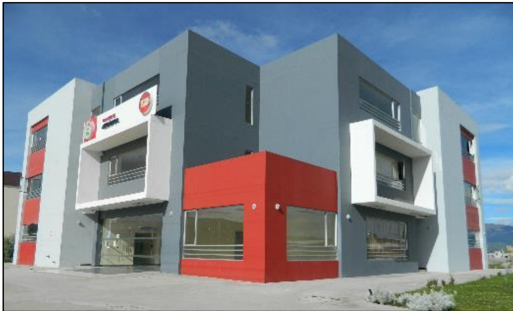
Figura 2-2: Fachada principal de Edificio Administrativo de la Facultad de Mecánica.
