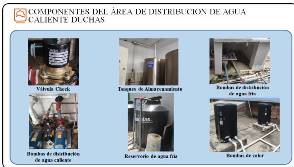
Ilustración 3-3: Componentes área de distribución de agua caliente ESPOCH Realizado por: Guzmán J; Núñez J. 2023.
