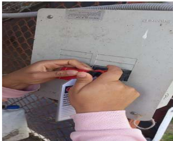
Ilustración 4-18: Implementación de bloqueo y etiquetado
