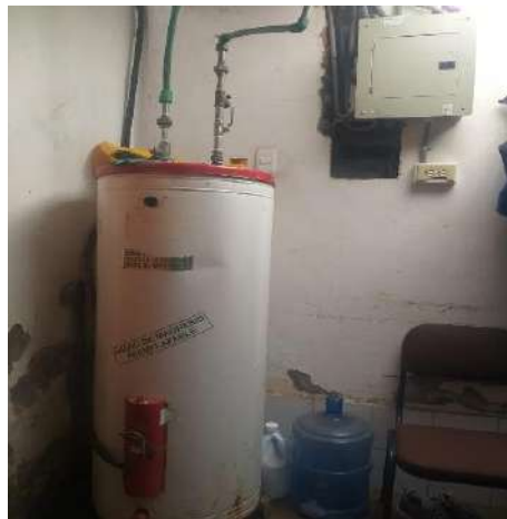
Ilustración 3-19: Calentador de agua
