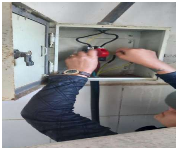
Ilustración 4-15: Implementación de bloqueo y etiquetado
