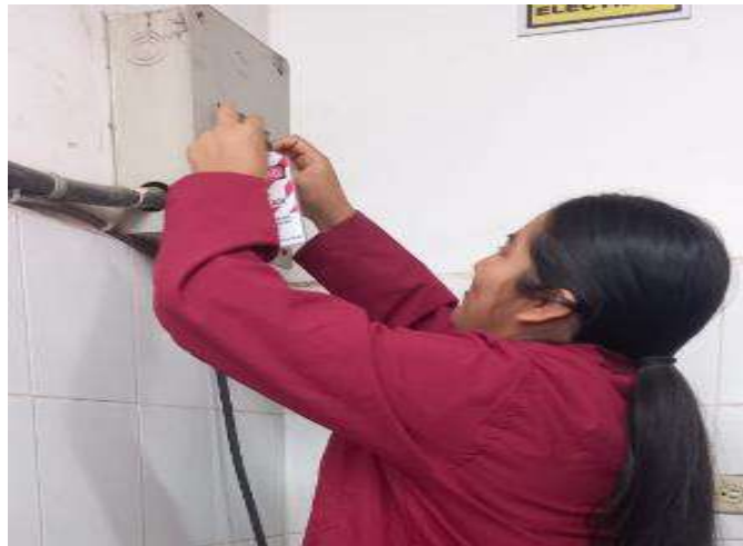
Ilustración 4-17: Implementación de bloqueo y etiquetado
