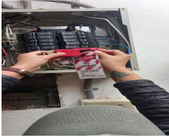
Ilustración 4-16: Implementación de bloqueo y etiquetado
