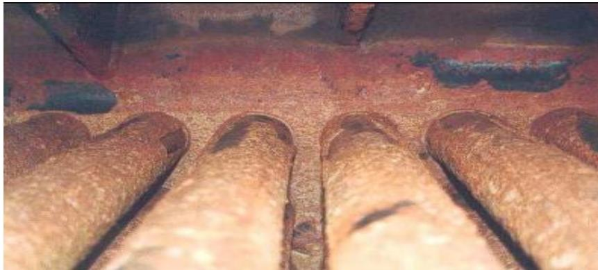
**Ilustración 4-2:** Presencia de incrustaciones en tubos de humo de una caldera pirotubular.
