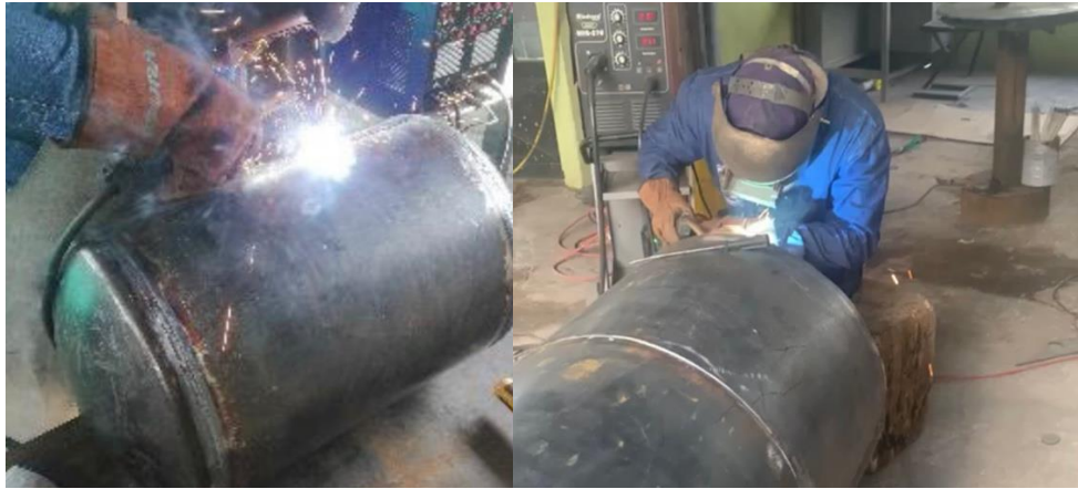
Ilustración 14-3: construcción de cubiertas
