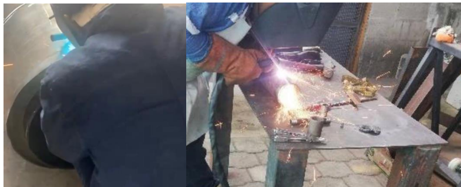
Ilustración 13-3: construcción del recipiente
