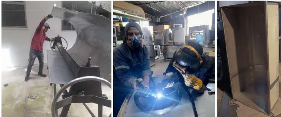
Ilustración 3-46: Fabricación del tanque de suministro de agua.
