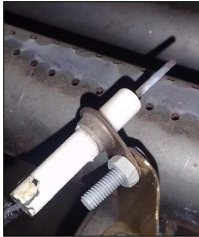
Ilustración 2-20: Sensor de llama.
