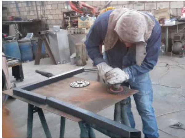
Armado de la estructura de la máquina desfibradora
