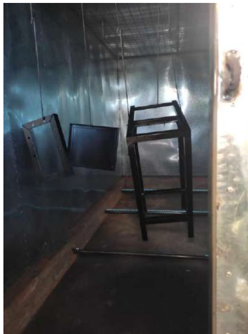
Preparación de los elementos estructurales para el pintado por horno
