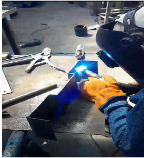
Construcción del elemento acoplador entre para la mesa deslizable
