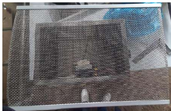
Ilustración 3-34: Corte de la malla electrosoldada.
