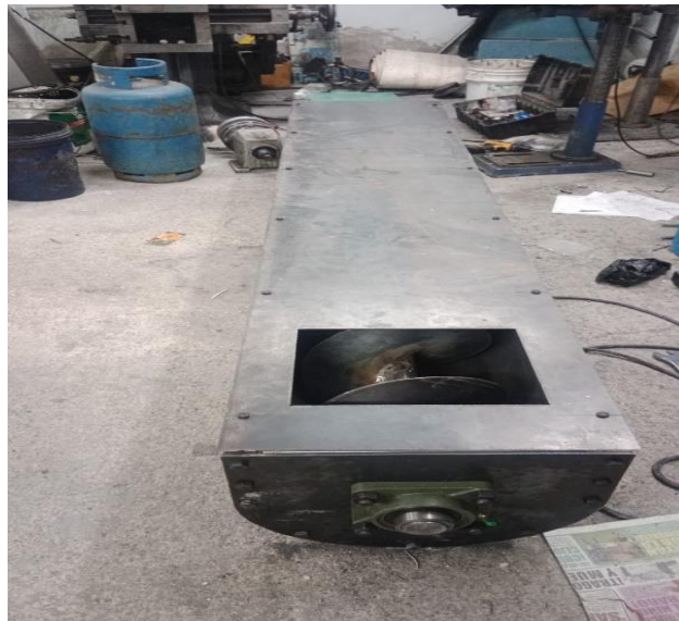
Ilustración 3-34: Colocación de la brida en la carcasa
