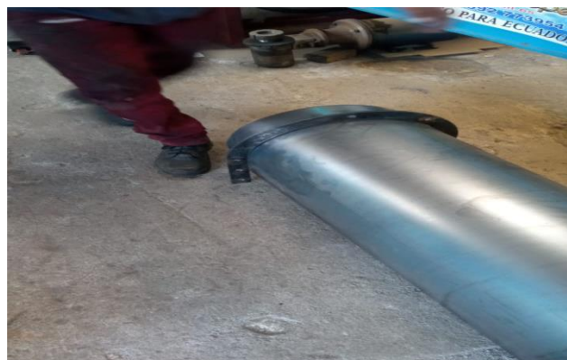
Ilustración 3-32: Colocación de la brida en la carcasa
