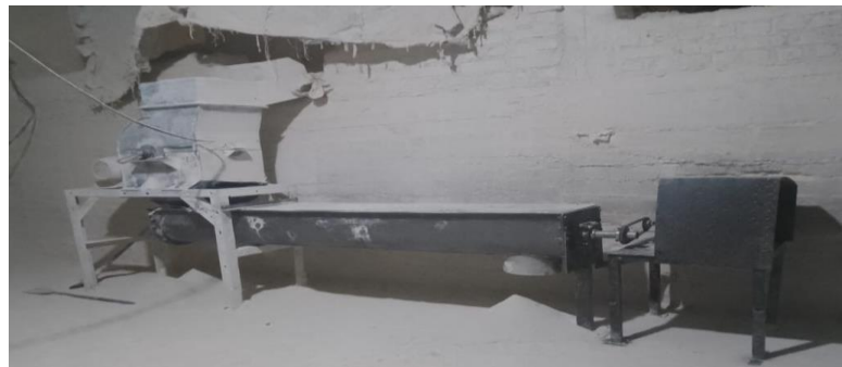
Ilustración 3-42: Montaje del sistema de control de expansión
