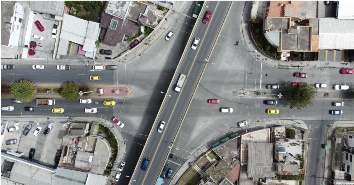
Figura 5-4. Vista aérea Av. La Prensa y Av. Lizarzaburu
