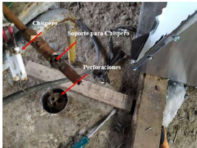
Figura 14-3: soportes para compactación de elementos. Realizado por: CUEVA, Cristian, 2020.
