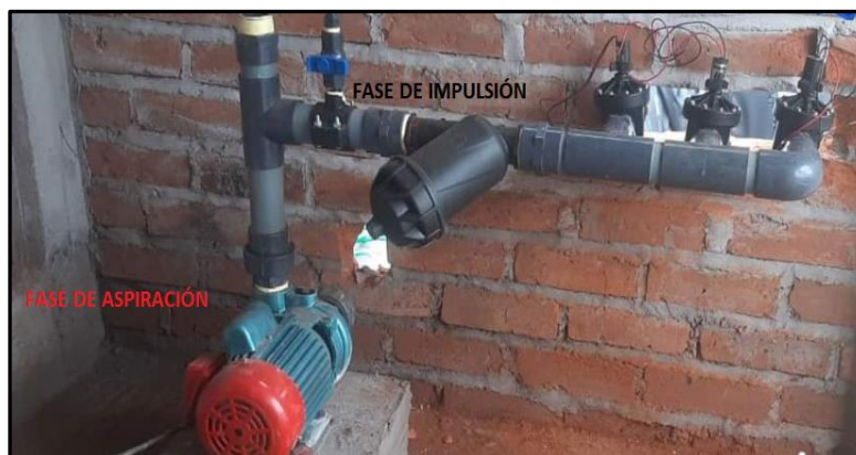
Figura 9-2. Sistema de Bombeo Realizado por: (Pérez y Castillo, 2021)
