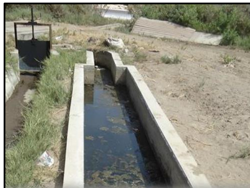
Figura 8-2. Desarenador Realizado por: (Pérez y Castillo, 2021)
