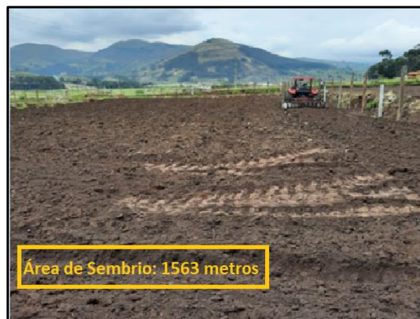
Figura 3-2. Nivelación del terreno Realizado por: (Pérez y Castillo, 2021)
