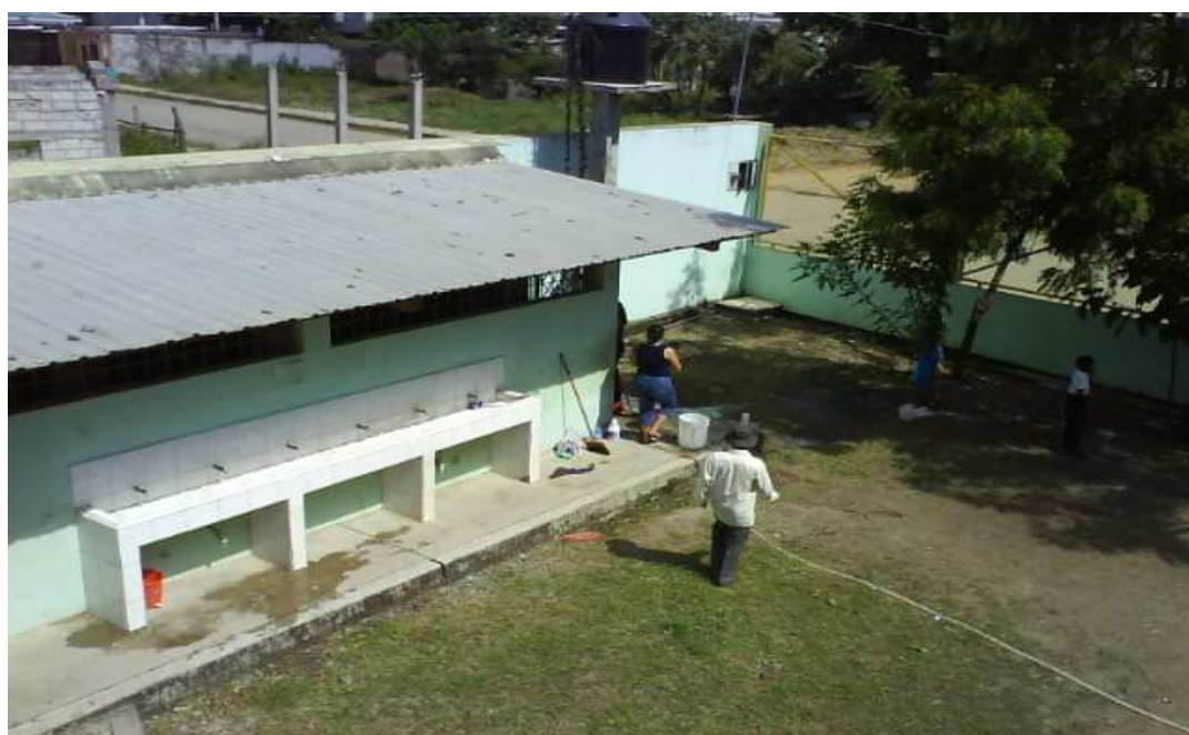
Foto № 6. Padres y madres de familia trabajando en el arreglo de las baterías sanitarias.
