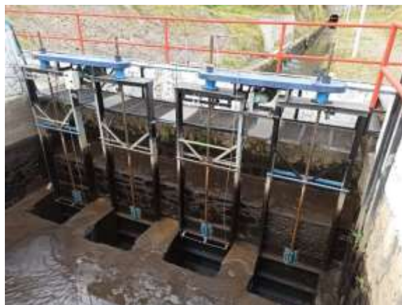
Figura 2-1: Compuertas 1 y 2 del sistema de Riego Chambo-Guano.
