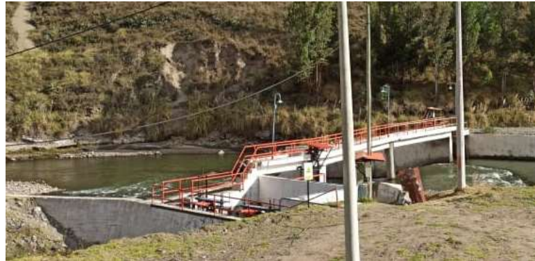
Figura 1-1: Bocatoma del sistema de riego Chambo-Guano.
