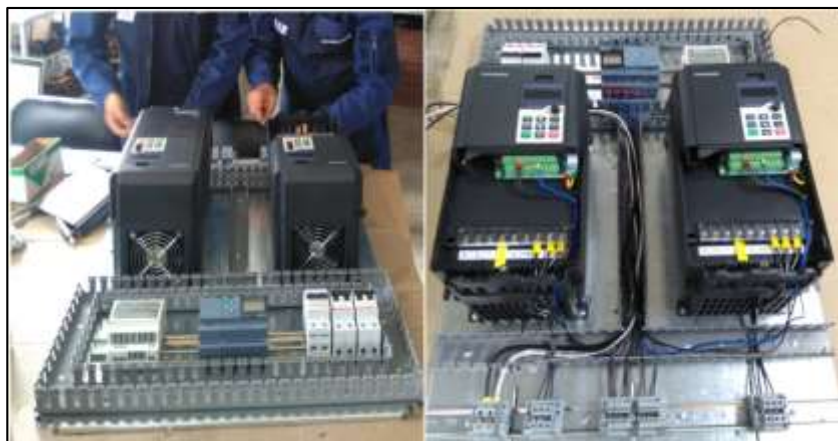
Figura 24-2: Montaje y cableado de elementos
