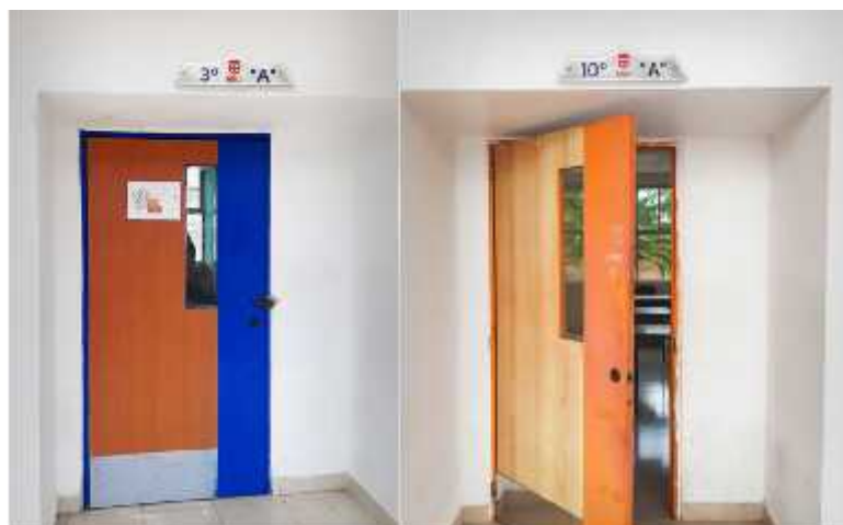
Ilustración 80-4: Señalética aulas de clases
