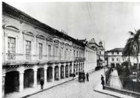
Figura 20-2: Palacio Municipal Fuente: arquitecturapanamericana.com, 2014
