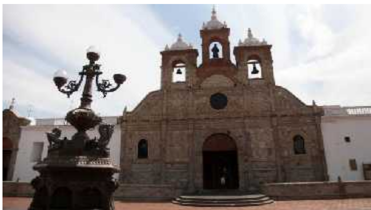
Figura 3-2. La fachada de piedra de la Catedral
