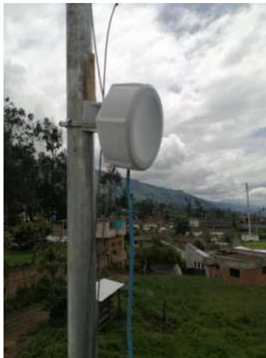
Figura 37-3: Instalación de la antena Mikrotik SXTSA5 en el mástil ubicado en el Nodo Quimiag
