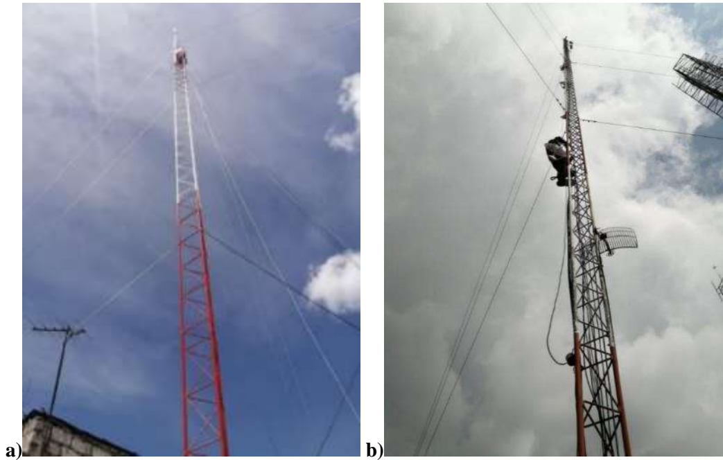
Figura 23-3: Instalación de las antenas Mikrotik LHG 5, a) torre ubicada en la empresa SITCOM y b) torre ubicada en el cerro San Francisco
