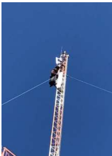
Figura 29-3: Instalación de las antenas Mikrotik SXTsq 5 en la torre ubicada en el Cerro San Francisco.
