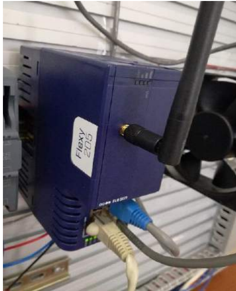
Figura 13-3: Montaje pasarela Ewon.
